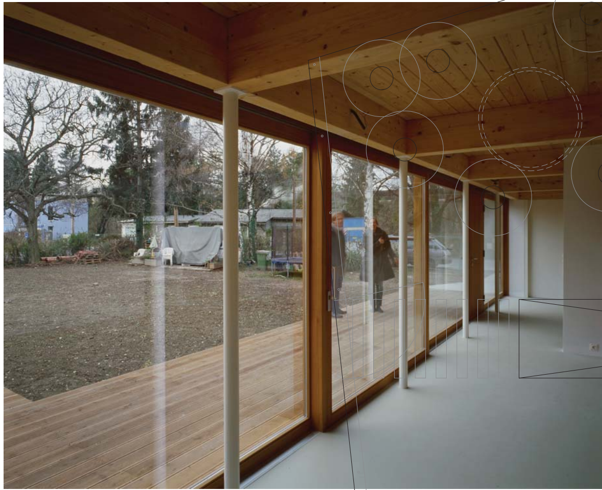
BLICK VOM ERDGESCHOSS IN DEN - NOCH NICHT FERTIGEN - GARTEN
